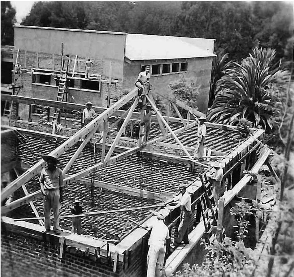
**Fig. 15** | Fotografía de la biblioteca en proceso de construcción que muestra la estructura de madera en erección. **Fuente:** Archivo fotográfico del CREFAL. 10-35.
