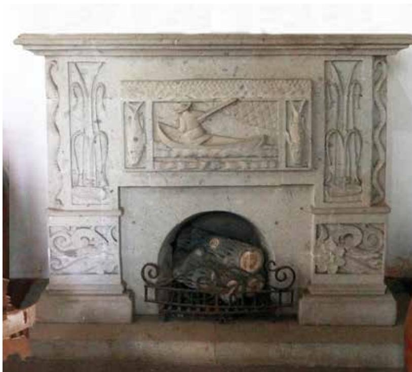
**Fig. 5** | Chimenea de la casita de campo, con troncos de concreto y evidente falta de tiro. **Fotografía:** C. Ettinger.
